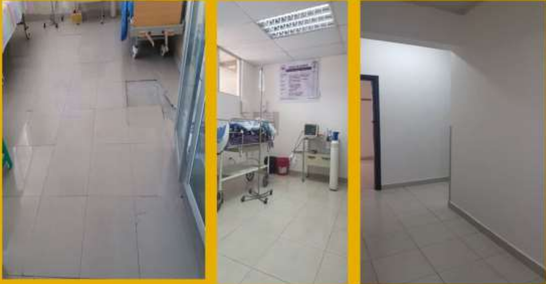
CAMBIO DEL PISO DE QUIROFANO
