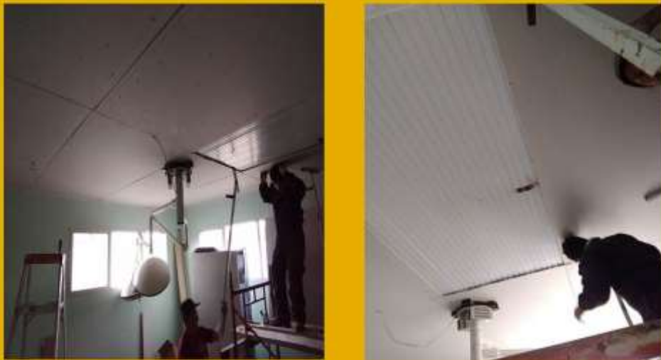
CAMBIO DEL TECHO DEL ÁREA DE QUIRÓFANO
